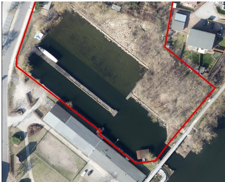
Abb. 9: Ausschnitt Areal Trockendock Quelle: Stadt Eisenhüttenstadt
