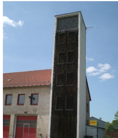
Abb. 6: Schlauchtrockenturm Quelle: Stadt Eisenhüttenstadt
