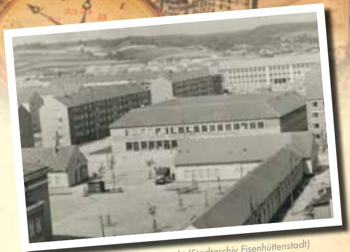
Foto: 1958 - Der Rohbau steht (Stadtarchiv Eisenhüttenstadt)
