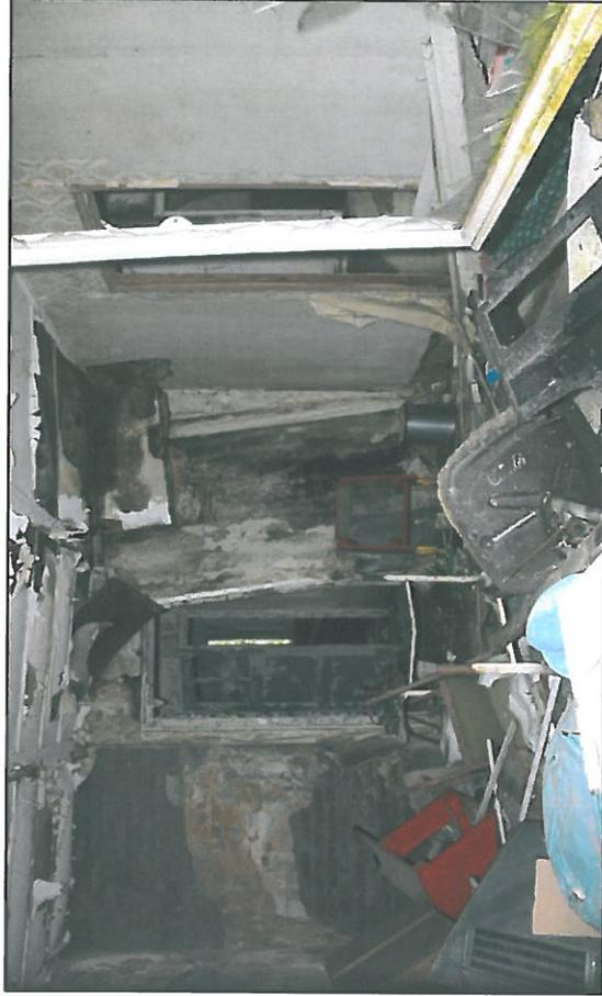
Abb. 18: Die Baracke ist einsturzfähig und konnte nicht betreten werden. Die Fenster wurden überall eingeschlagen, das Gebäudeinnere wird zur Müllablagerung genutzt.
