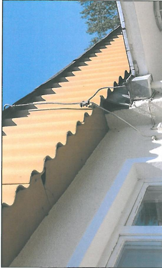
Abb. 10: V.a. der verkleidete Gesimskasten an der Nord- und Südseite des Gebäudes weist Zugangsmöglichkeiten für Fledermäuse und Höhlenbrüter auf.
